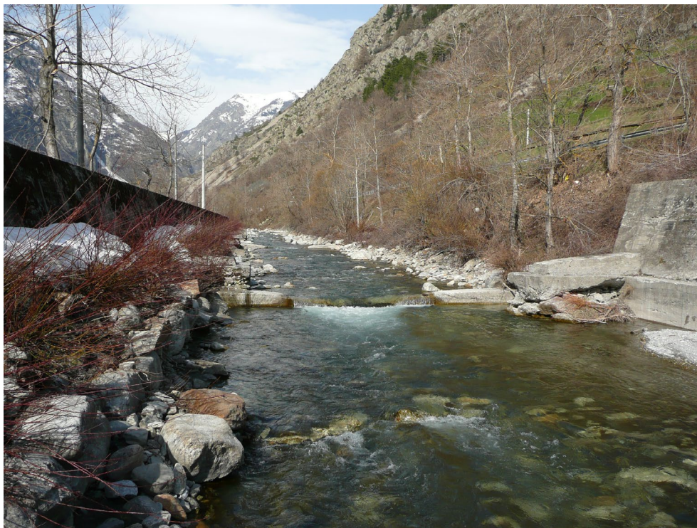
Fig. 9.3: soglie di fondo da eliminare in quanto elemento di disturbo per la corrente
