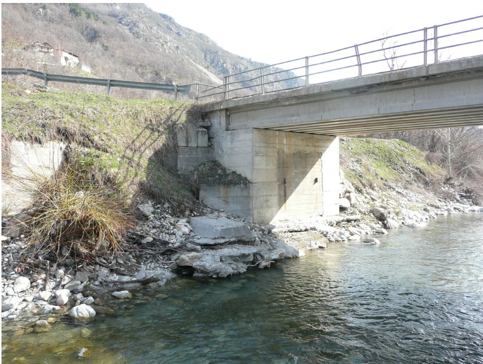
Fig. 9.2: ponte per località Roviera che verrà sostituito con un attraversamento con luce maggiore (opere previste in altro progetto già finanziato e appaltato)
