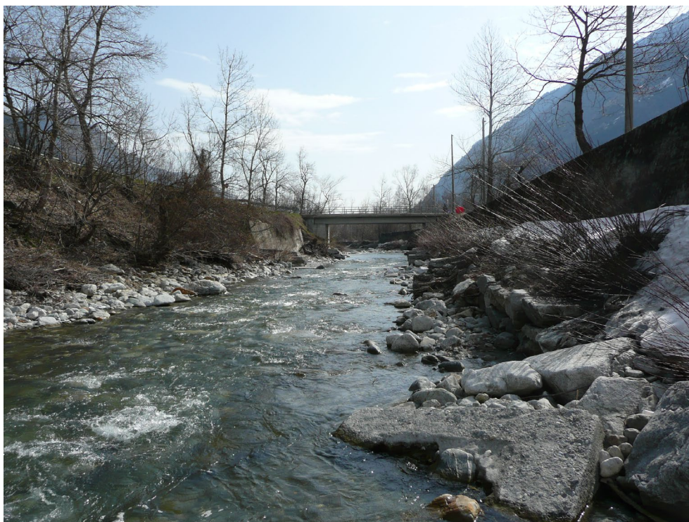
Fig. 9.4: pennelli inefficienti da eliminare in quanto elemento di disturbo per la corrente (in basso a destra)
