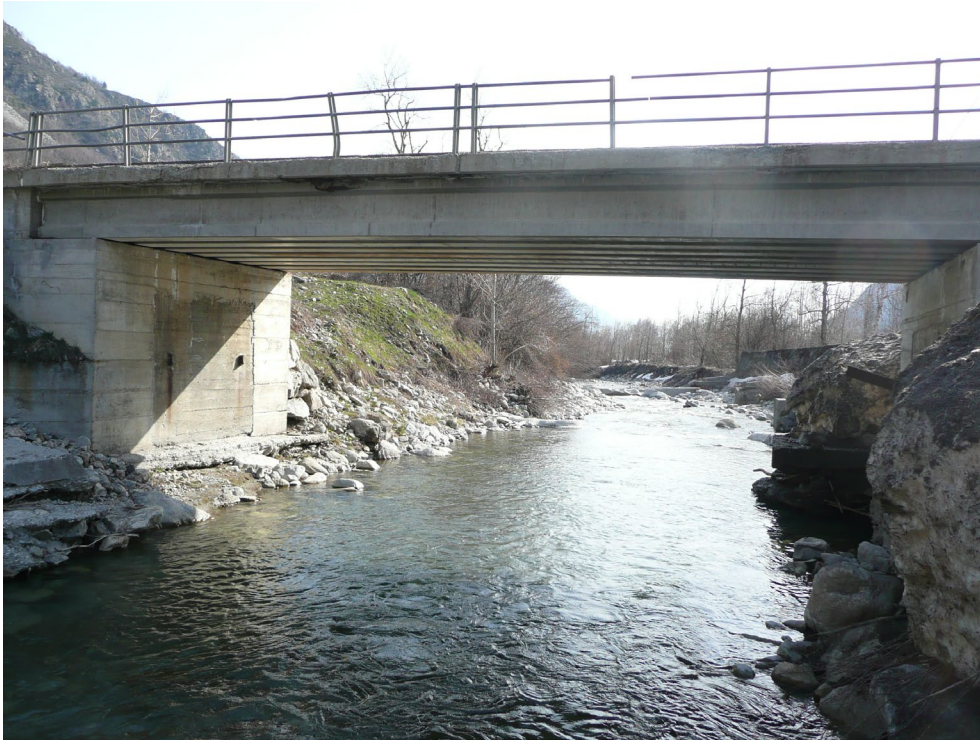
Fig. 9.1: ponte per località Roviera che verrà sostituito con un attraversamento con luce maggiore (opere previste in altro progetto già finanziato e appaltato)
